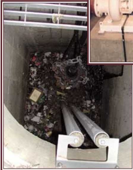
Pumpning av rens
